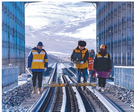
马祎俊(左二)在使用轨道检测车检查铁轨情况。人民日报记者 徐取尧 摄
