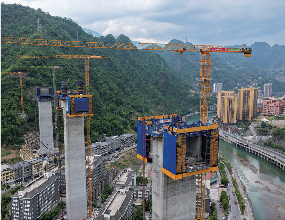
这是5月28日拍摄的西渝高铁任河特大桥建设现场(无人机照片)。 5月28日,随着最后一方混凝土浇筑,由中铁十二局承建的西渝高铁城口任河特大桥主桥墩施工顺利完成,标志着大桥进入梁部施工阶段,为全线通车奠定了坚实基础。 西渝高铁城口任河特大桥位于重庆市城口县境内,全长1180.52米,共有墩台10个,最大墩高135米,为西渝高铁康渝段重难点工程。 西渝高铁是全国“八纵八横”高速铁路通道之“包(银)海、京昆通道”重要组成部分,全长330公里,设计时速350公里。 新华社记者唐奕摄
