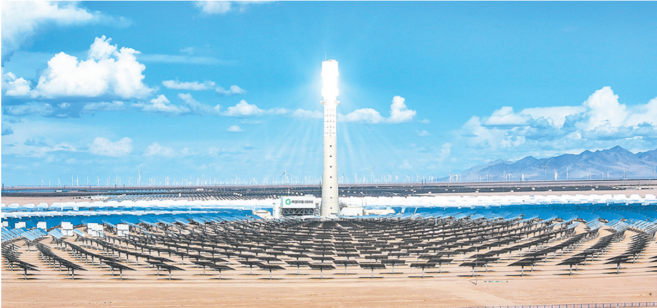
中国绿发青海分公司海西州多能互补集成优化国家示范工程内热熔盐发电场。
