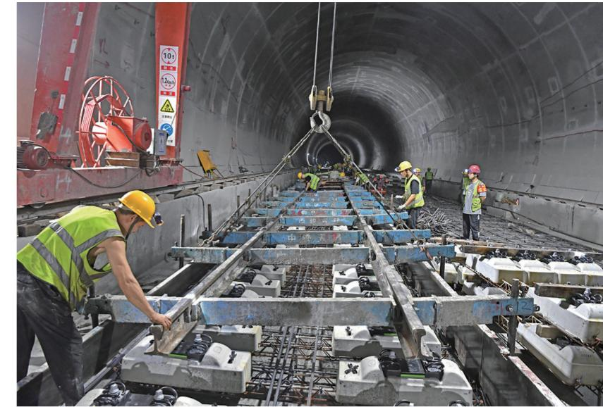
5月16日，工作人员在中铁五局南玉铁路6标段平悦隧道进行无砟道床轨排安装作业。
