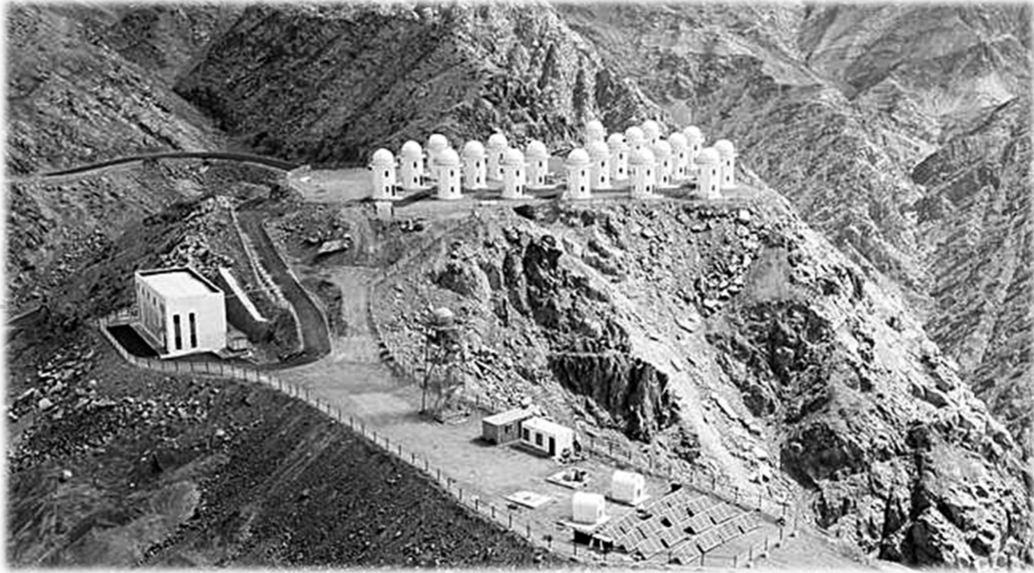
4月12日拍摄的冷湖天文观测基地一处在建天文望远镜项目。 陈杰 摄
