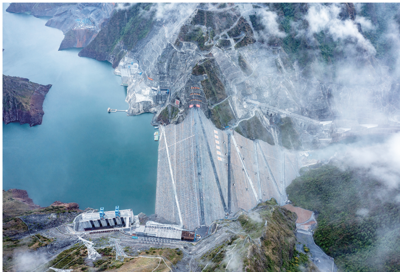
这是两河口水电站(6月22日摄,无人机照片)。
