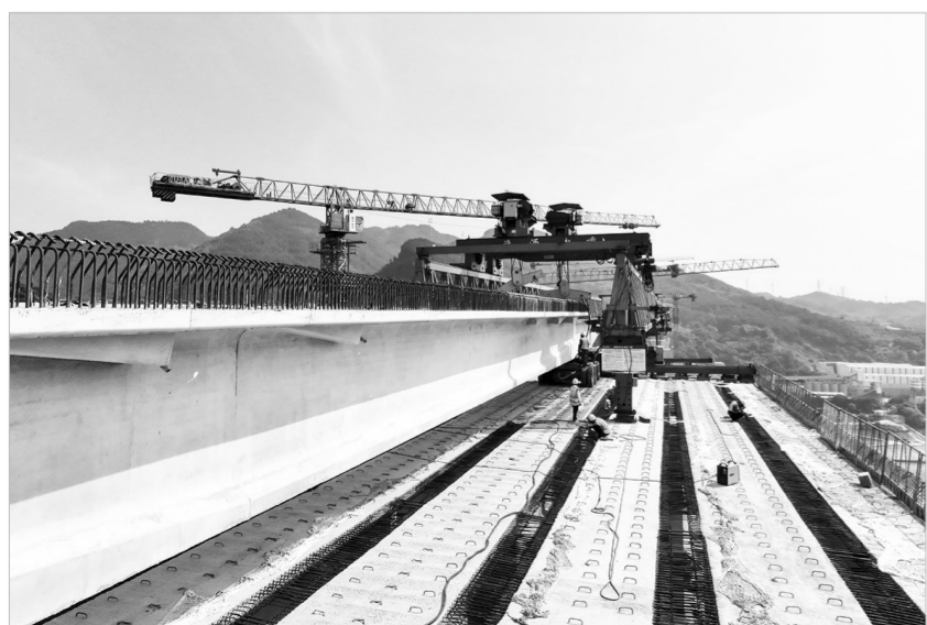
7月10日,施工人员在重庆市北碚区渝武高速复线观音峡嘉陵江特大桥架梁引桥T梁(无人机照片)。
