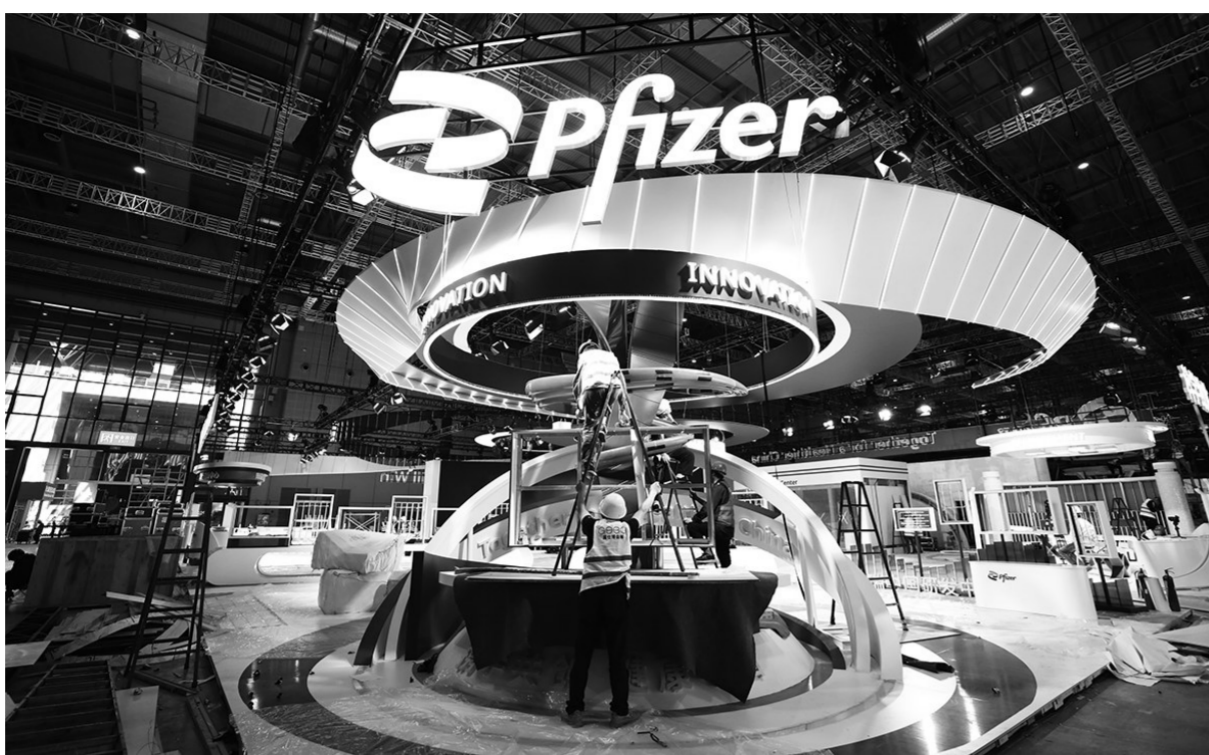
工作人员在国家会展中心(上海)内部布展施工(10月29日摄)。
