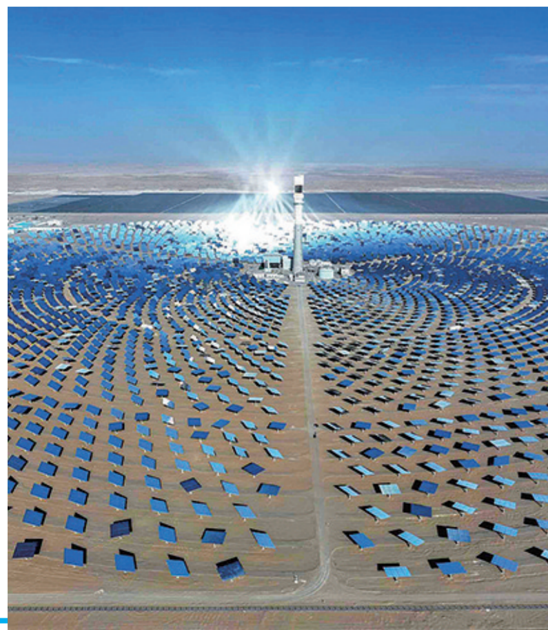
鲁能格尔木多能互补工程50MW塔式光热电站源源不断地将太阳能转化为电能,为绿色算力提供有力支撑。
