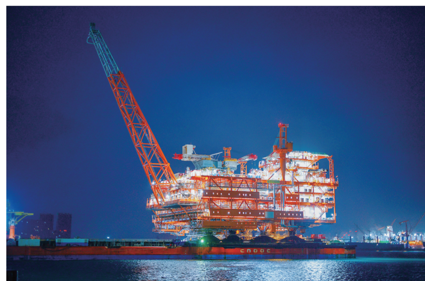
這是11月14日清晨在山東青島拍攝的渤中26-6油田一期開發項目中心平台裝船作業現場（無人機照片）。
