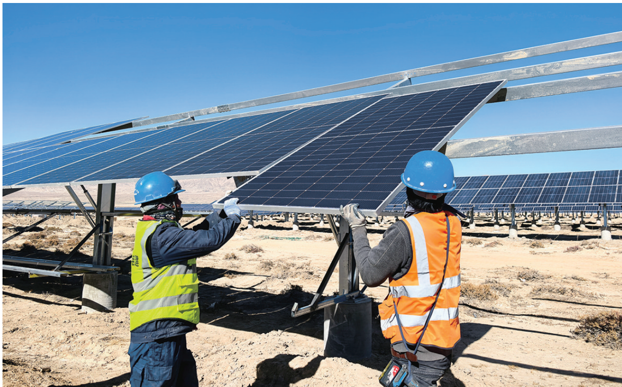
建设现场，工人们正在安装光伏板。
