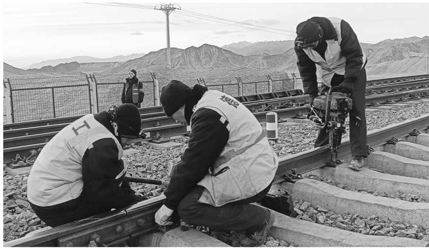
春节期间他们坚守一线保障铁路运输安全。
