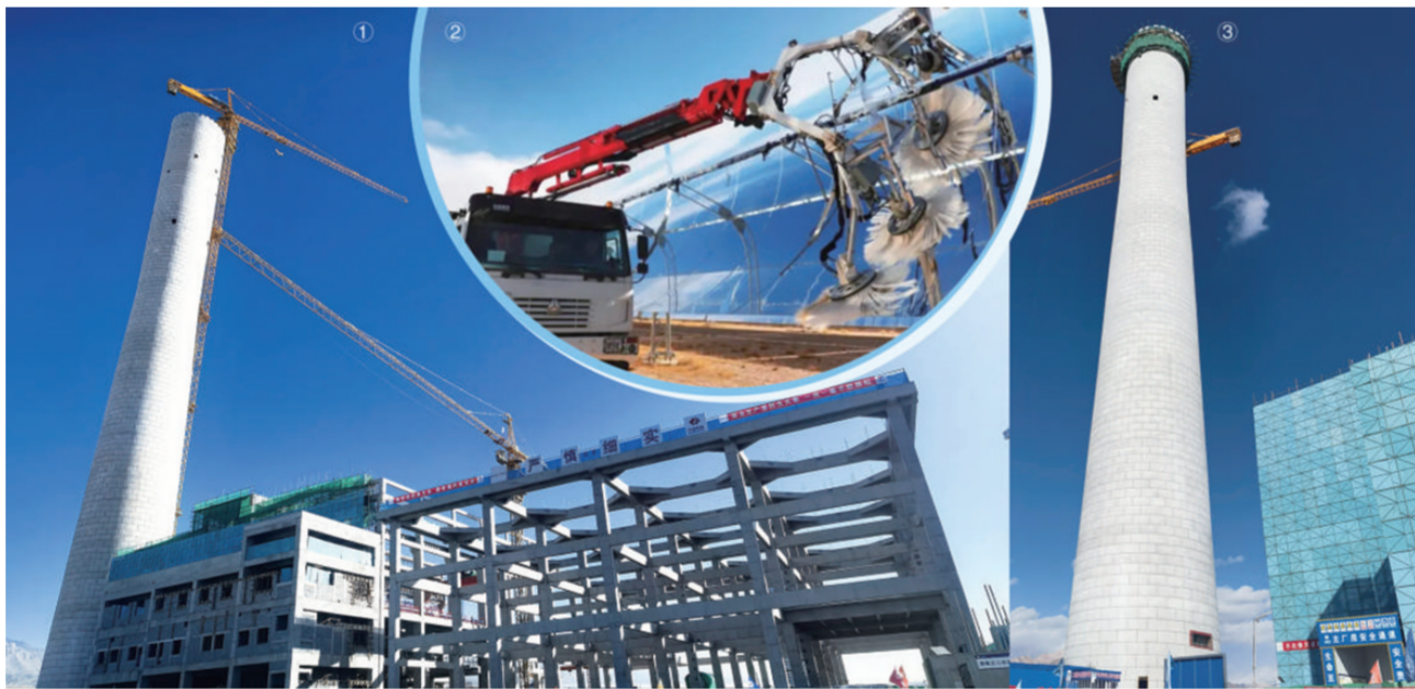
图①中广核德令哈 200 万千瓦光热储一体化项目建设现场。图②中广核德令哈 50 兆瓦光热示范项目反射镜智能清洗车正在进行镜面清洁。图③中广核德令哈 200 万千瓦光热储一体化项目中 20 万千瓦光热项目混凝土结构的吸热塔。
