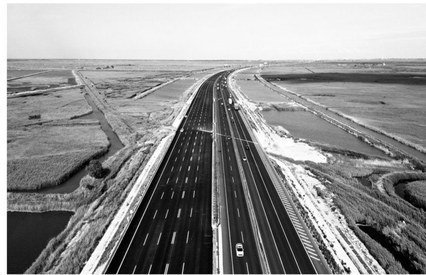
6月23日拍摄的已经完工的京哈高速盘锦段改扩建工程（无人机照片）。
