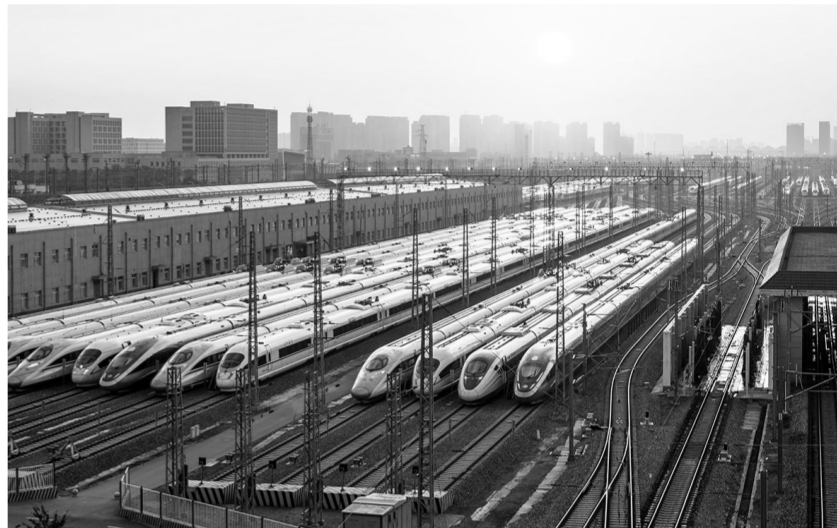
2月1日,国铁西安局西安动车段动车库内高铁动车组整齐列阵(无人机照片)。
